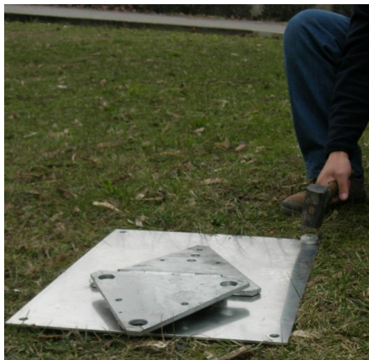
Fissaggio della piastra DYA320 a terreno tramite picchetti
